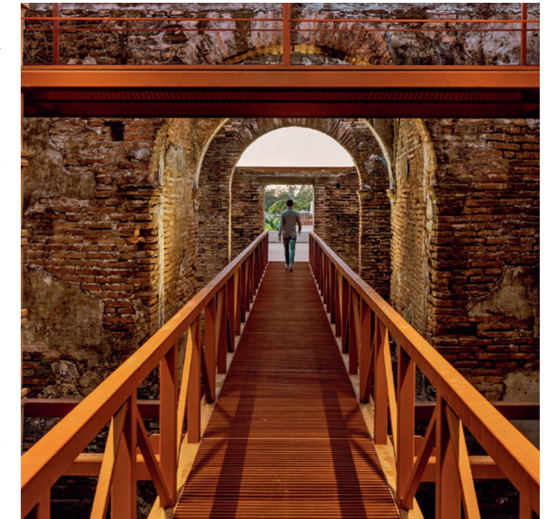
Colectivo C733, Centro cultural Aduana, San Blas
