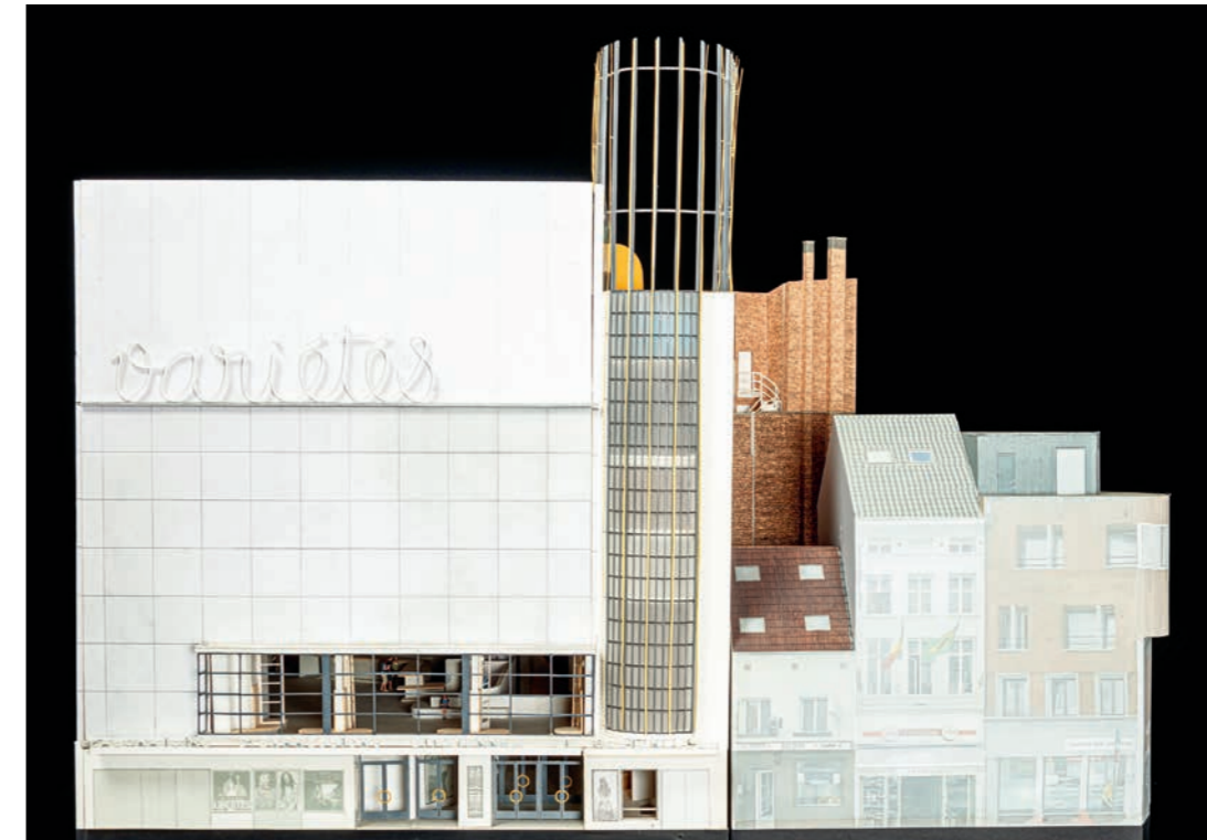
Die Aufstockung über dem Haupteingang ermöglicht die Unterbringung des 450 Sitz- und 900 Stehplätze fassenden großen Veranstaltungssaals.
