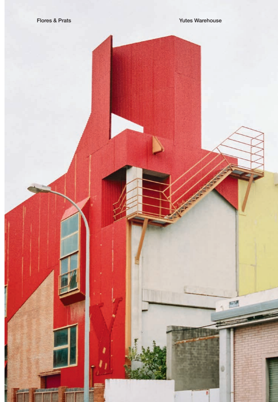
Die Blechfassade umhüllt den Bau auf keiner Seite vollständig, sondern lässt immer wieder die neuen Beton- und Metallstrukturen oder altes Mauerwerk hervortreten.
