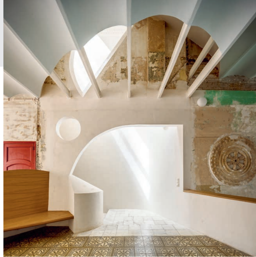
Über eine neue Öffnung im Dach und zwei halb-runde Deckendurchbrüche erhält das Foyer natürliches Licht.
