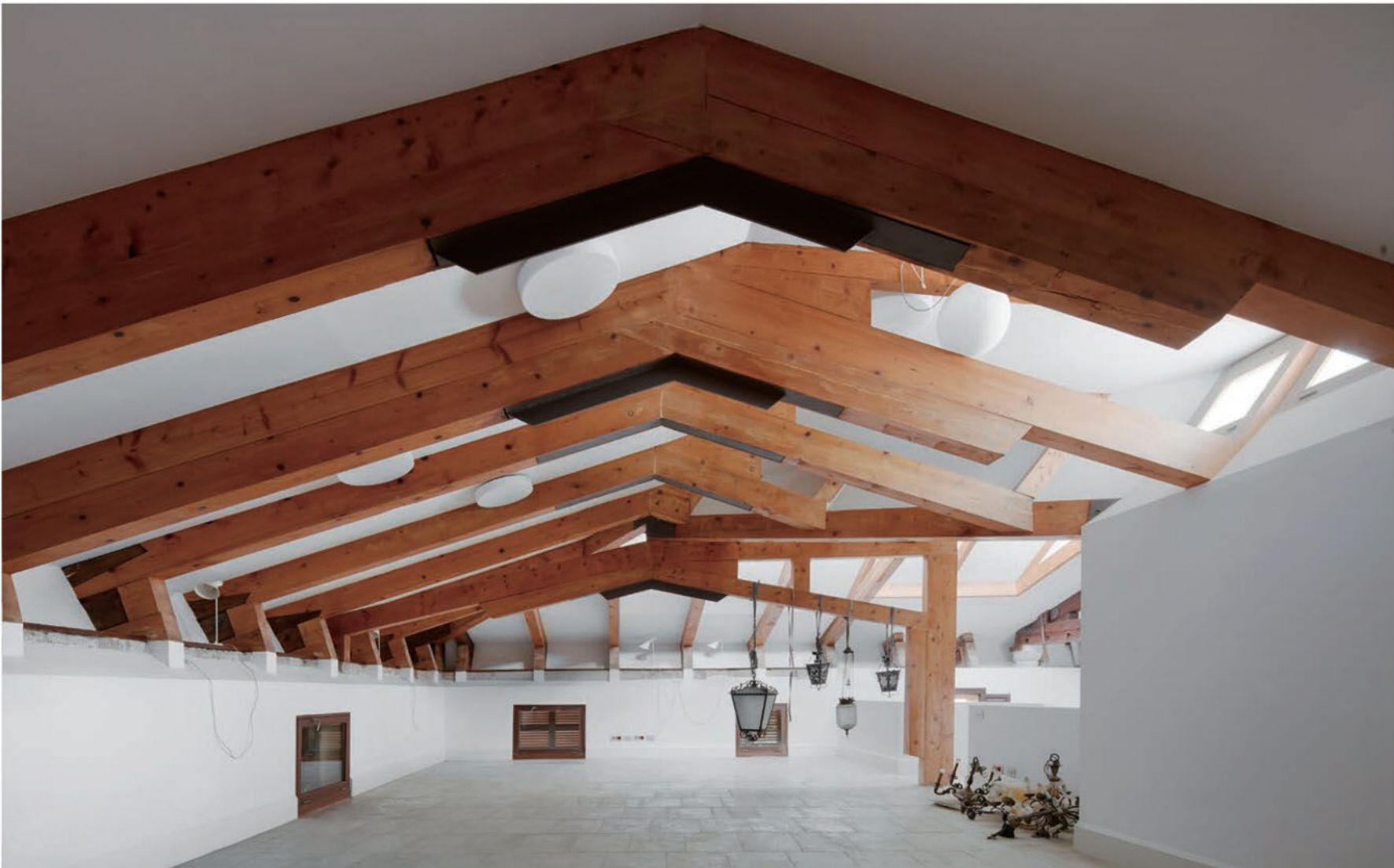
커스터마이징 목재 보로 구축한 3층의 도서관 공간이다. It is a library on the third floor built by customized wooden beams.
