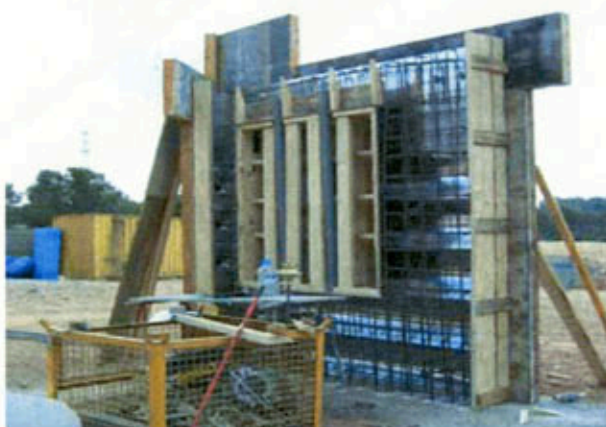
IMATGE DEL SISTEMA D'ENCOFRAT I ARMAT DEL MUR
