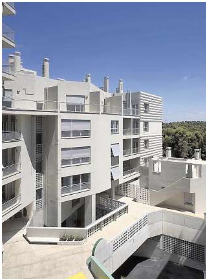
Viviendas en Torresana (Terrassa) de Flores&Prats Arq.
